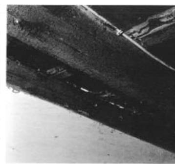
Offenes Dach, Deckung undicht
