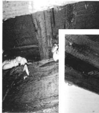
Reparaturversuch mit Bauschaum
